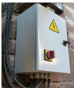
L'installation d'une protection départ de ligne par disjoncteur différentiel tétrapolaire (400V C10 – 300MA) a été effectuée sur le départ général de l'alimentation électrique des cloches au niveau du tableau général électrique. Le montant total HT de ces travaux s'est élevé à 3376 euros. Vous êtes invités à consulter le site de la commune de Nauviale à la rubrique CULTE « les cloches de nos églises » pour écouter le carillonnement individuel ou simultané des deux clochers.
